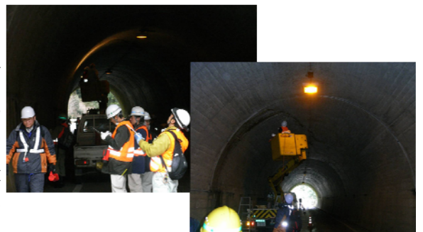
フィールド実習(トンネルの維持管理)
