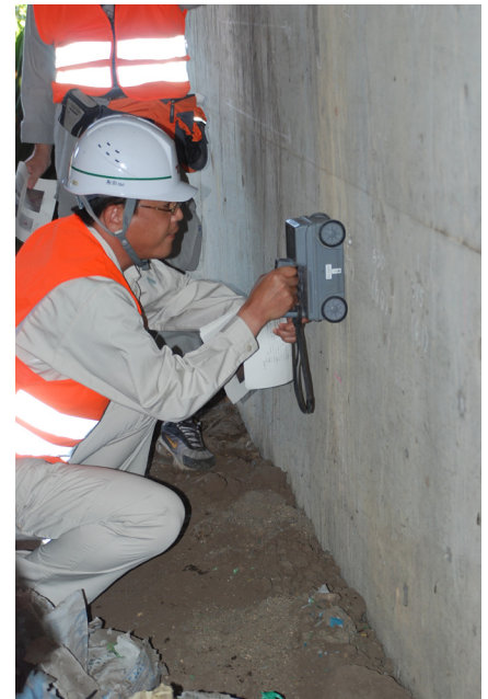
最新の機械を使って．．． (コンクリートの非破壊検査)
