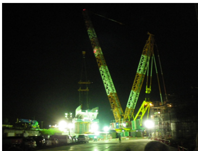
9月13日 現場見学会風景(巨大クレーンを用いた桁の一括架設)
