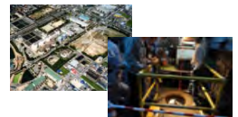
松山市中央下水処理場
