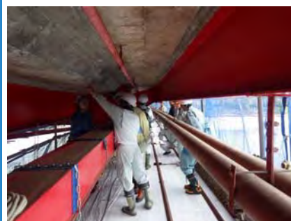
補強工事現場の見学
