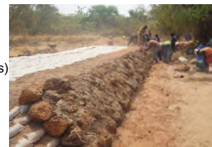
Construction de mur latéral
