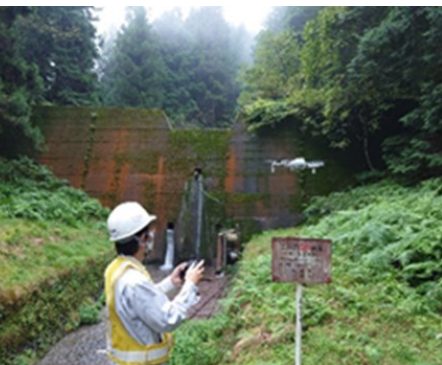
写真-3 ドローンによる橋梁・砂防施設の点検状況
