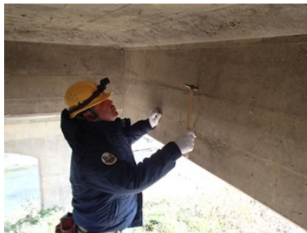
写真-2 MEによる施設点検状況
