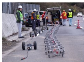
FWD試験・表面波探査・電気探査状況
