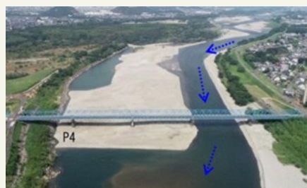
上段：施工前 下段：施工後
