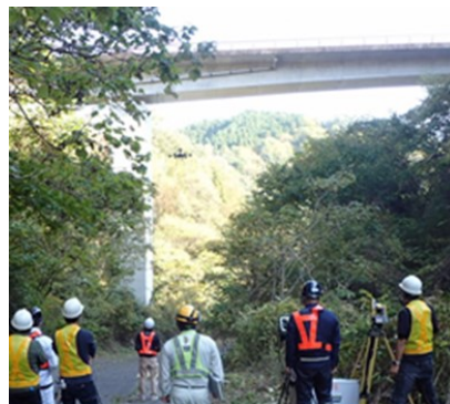
写真-3 ドローンによる橋梁・砂防施設の点検状況
