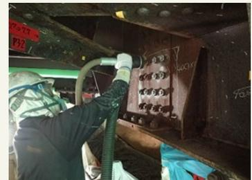
高力ボルトの取替工事
