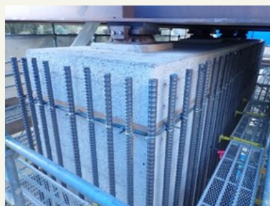
配筋状況（帯筋施工前）
