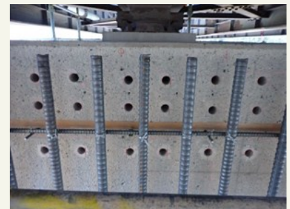
配筋状況（アンカー、帯筋施工前）
