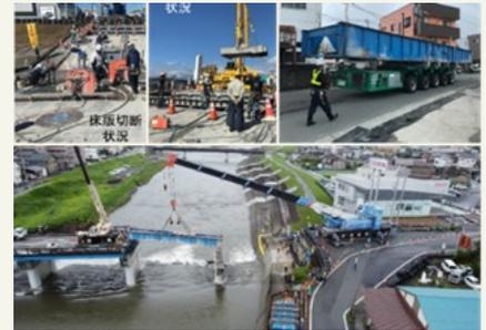
写真-2 上部工撤去状況
