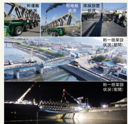
写真-3 応急組立橋架設状況
